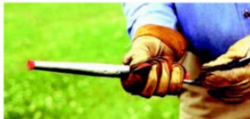
**Figura N°11. Medir Extremos del Conductor.**
