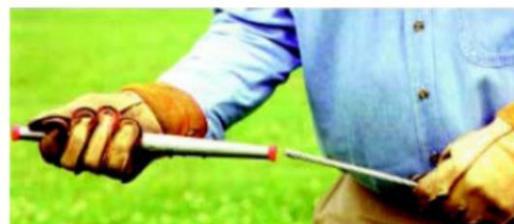
**Figura N°12. Medir Extremos del Conductor.**
