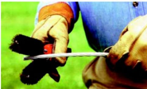
**Figura N°10, Inspección y Limpieza del Conductor.**
